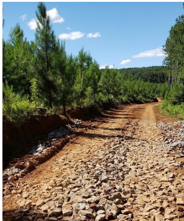
Figura 27. Adição de cascalho em pontos críticos das estradas.
