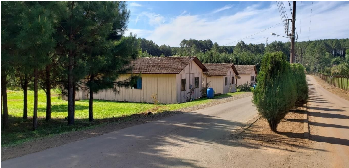
Figura 34. Moradia de trabalhadores com pintura nova.
