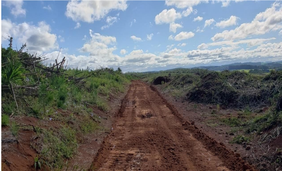
Figura 26. Retífica de estradas dos talhões T94, T95, T26 e T27.
