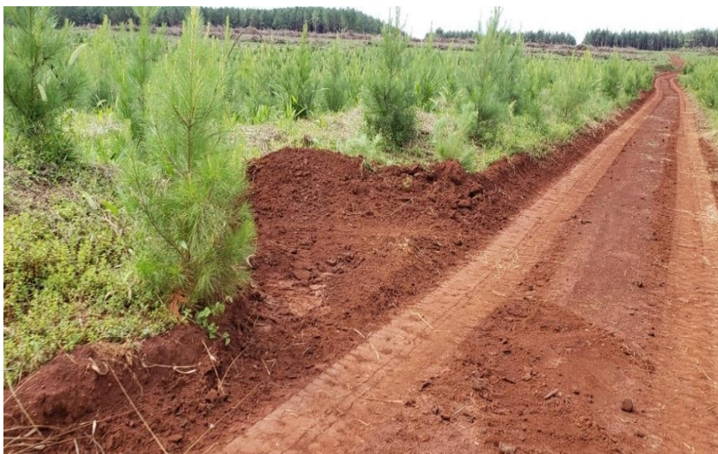
Figura 25. Construção de valas para escape de água.
