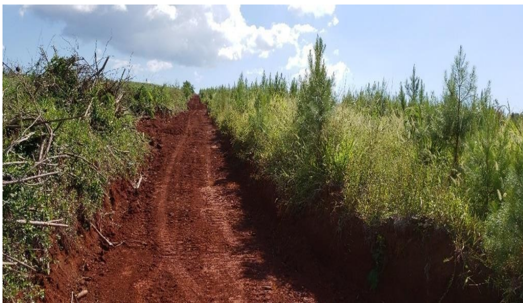
Figura 25. Construção de valas para escape de água.
